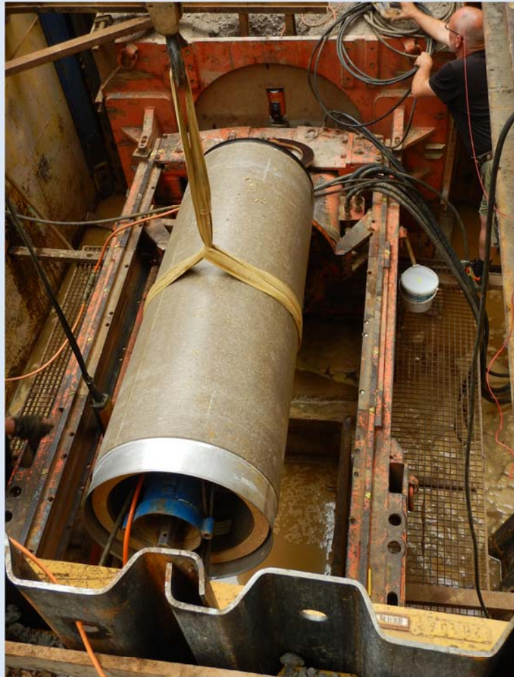
Einbau eines Vortriebsrohres in die Vortriebsmaschine in der Hardystraße
