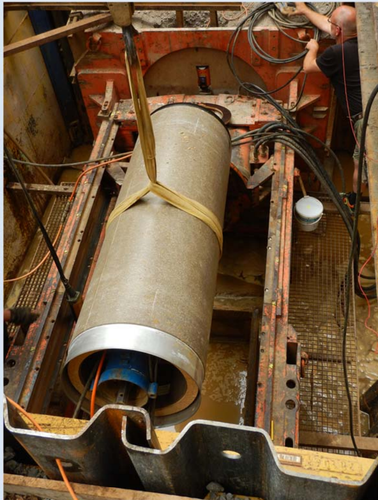
Einbau eines Vortriebsrohres in die Vortriebsmaschine in der Hardystraße
