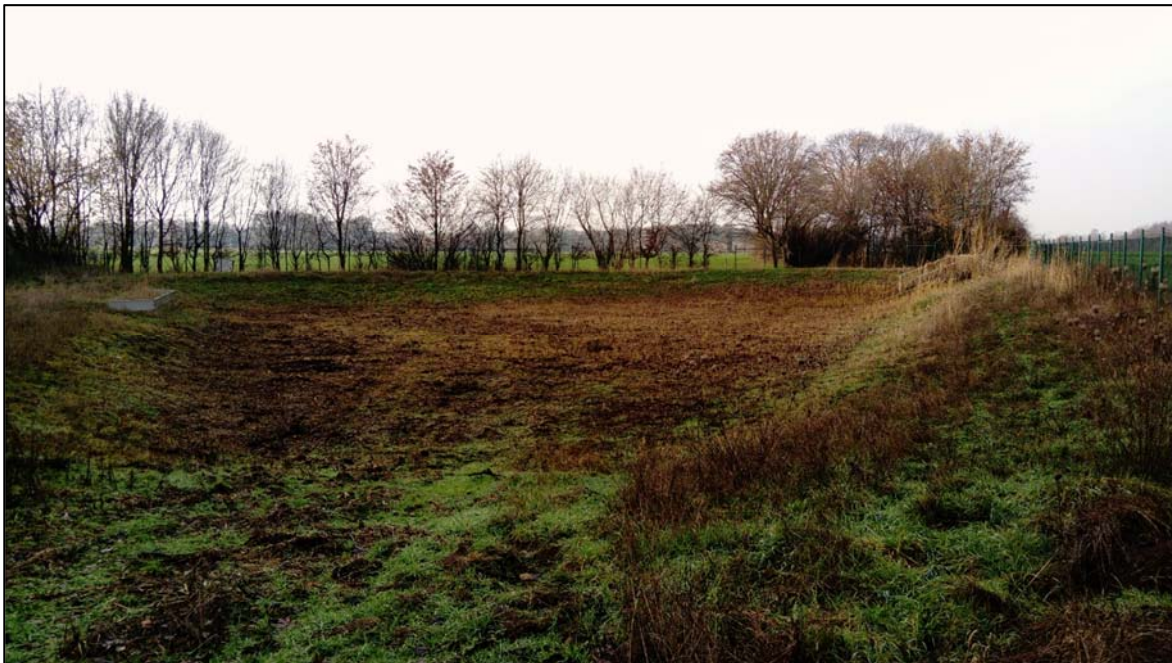
Abb.: Bestehender Retentionsbodenfilter (RBF) vom Abwasserbetrieb Warendorf
